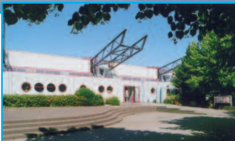
Eingang zur Tennishalle
